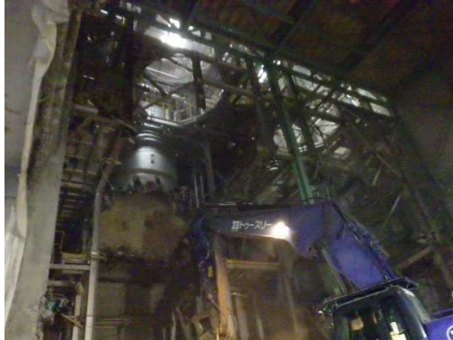
① 焼却設備解体イメージ
