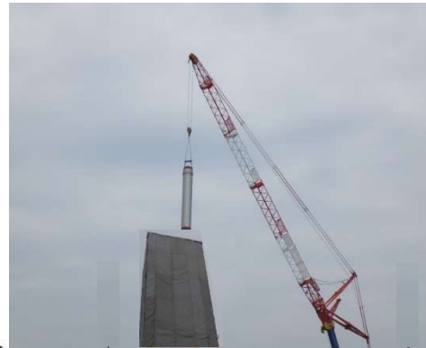
①内筒切断撤去イメージ
